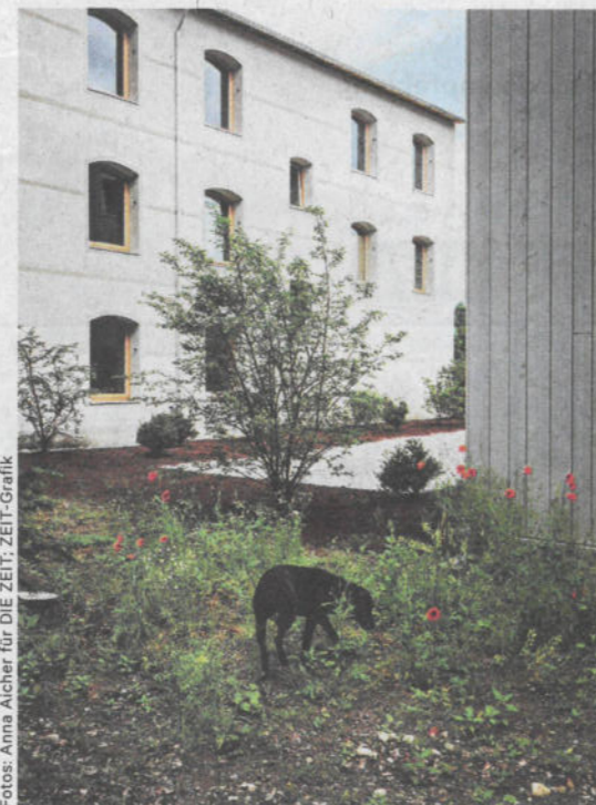
Die Prototyp-Häuser in Bad Aibling: Aus Leichtbeton (oben) und Ziegel (u. l.)
