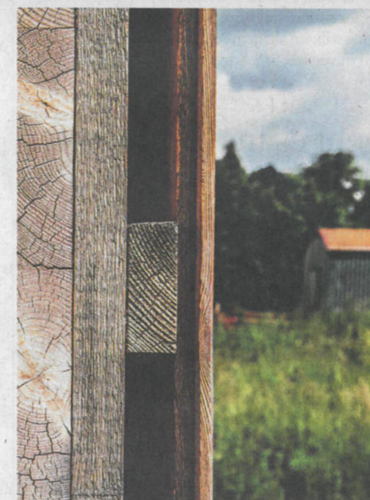
Die Wand des Holzhaus-Prototyps in der Seitenansicht
