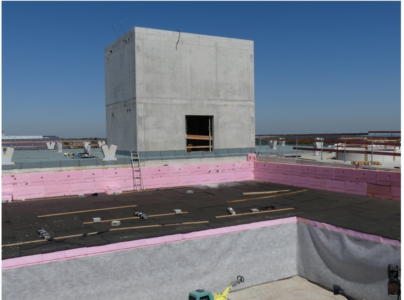
Blick auf das Treppenhaus
