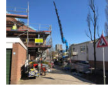
Impression von einer Energiesprong-Baustelle im niederländischen Zoetermeer. Foto: dena
