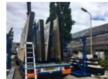
Hoher Vorfertigungsgrad: Fassadenelemente für eine serielle Sanierung. Foto: dena
