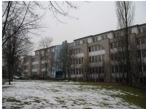
Foto 36: GE Karlsruher Allee, Büronutzungen
