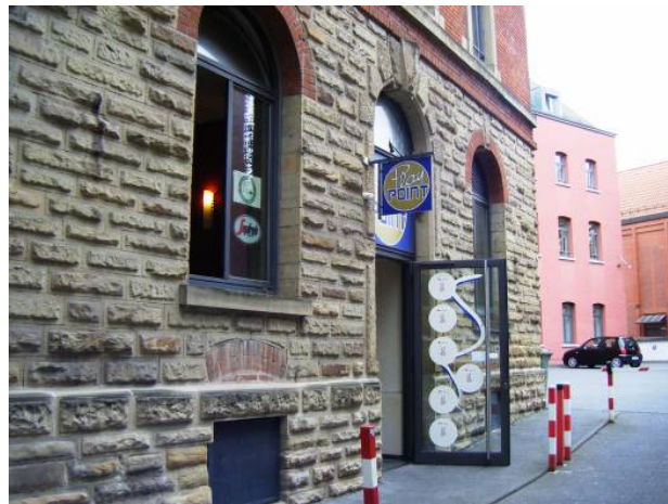
Abb. 8: Standort in der Myliusstraße
