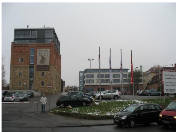
Foto 41: GE Pflugfelder Straße
