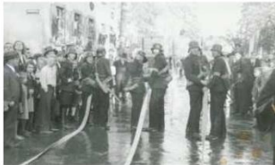
Festumzug "Oberes Tor" über Hauptstraße Richtung Marktplatz. Links Abnahme der Wettkämpfe in der Karlstraße auf Höhe des ehemaligen Ziegeldoms.
