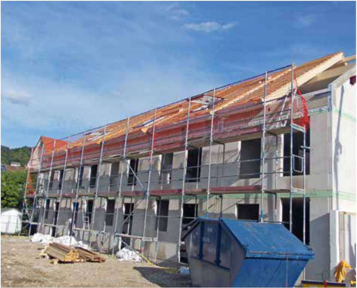
Von der Baustelle ...
