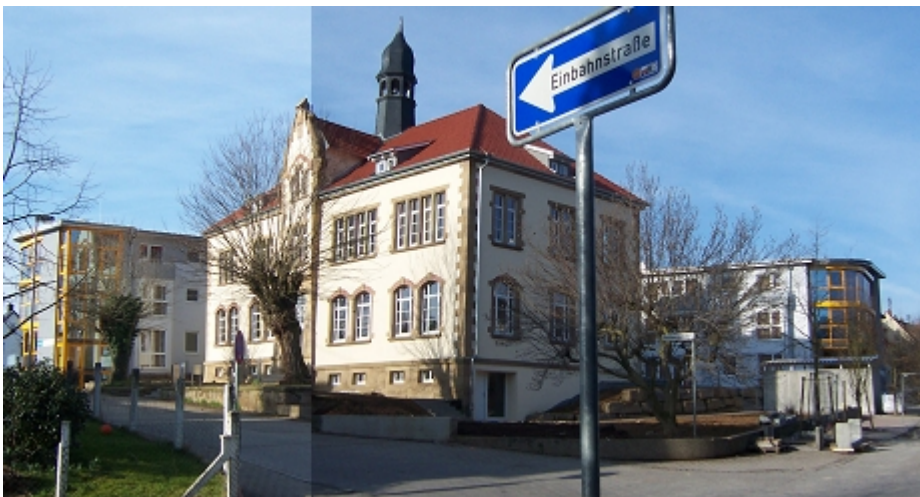
Abbildung 8: Seitenansicht des Haus der Generationen
