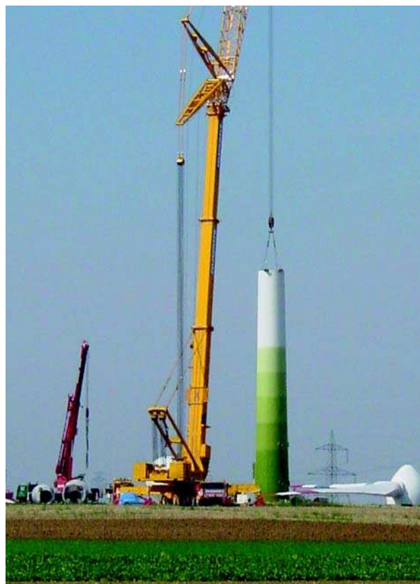
Windpark Bruck/Leitha: Halfertiger Stahlrohrturm mit zusammengebautem Rotor
