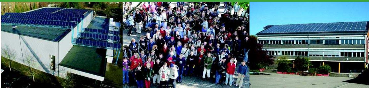
Photovoltaikanlagen des Willibrord-Gymnasiums in Emmerich am Rhein und des Aggertal-Gymnasiums in Engelskirchen
