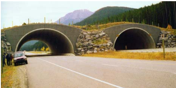
Abb. 10: Beispiel einer Grünbrücke
