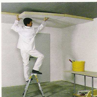
Dämmung Kellerdecke
