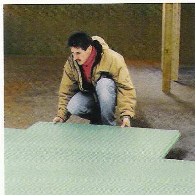
Dämmung Kellerfußboden
