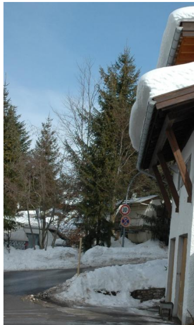
Abbildung 3: drohende Dachlawine, Foto Heiko Joos
