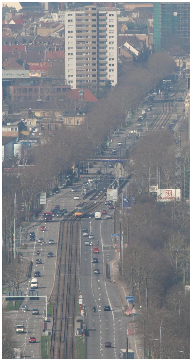
Bundesstraße B10 in Karlsruhe-Durlach (Foto LUBW)
