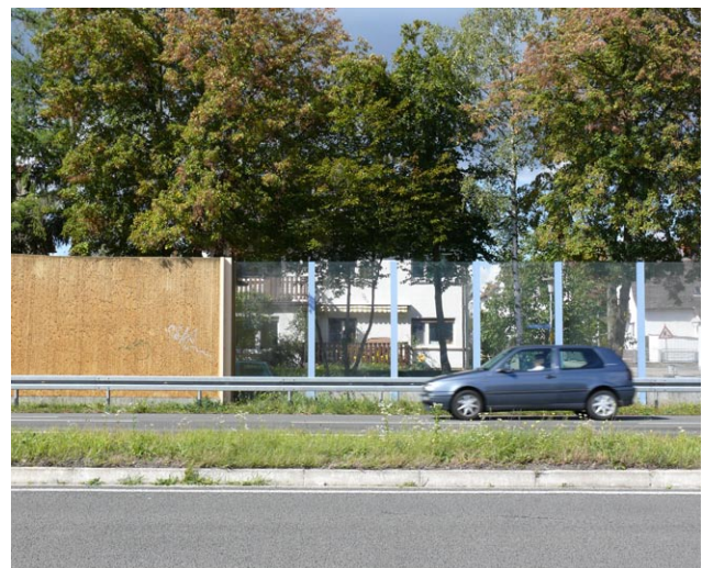
Lärmschutzwand aus unterschiedlichen Materialien. Hier sind undurchsichtige und durchsichtige Elemente miteinander kombiniert. Durchsichtige Elemente haben den Nachteil, dass sie über keine schallabsorbierenden Eigenschaften verfügen, vermeiden aber eine durch Lärmschutzwände ansonsten auftretende optische Trennwirkung. Ggf. sind zum Schutz von Vögeln geeignete Maßnahmen vorzusehen (Vermeidung von Vogelschlag). (Foto LUBW)
