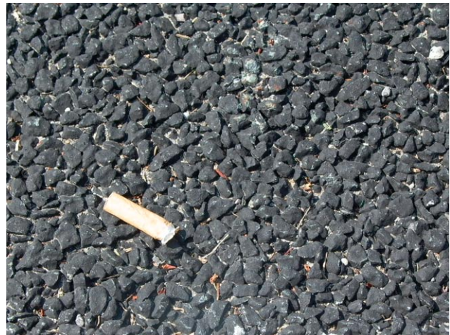
Nahaufnahme der Oberfläche eines zweilagig offenporigen Asphaltes - zum Größenvergleich dient eine Zigarettenkippe - (Augsburg, Foto LUBW)
