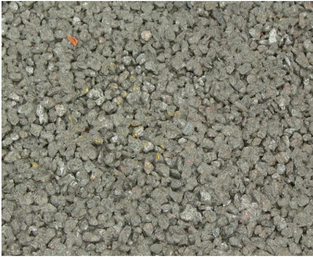
Offenporige Betonfahrbahndeckschicht. Derzeit liegen weniger Erfahrungen und Anwendungsbeispiele für Betonbauweisen vor als bei Asphalt (Hockenheimring, Teststrecke, Foto LUBW)
