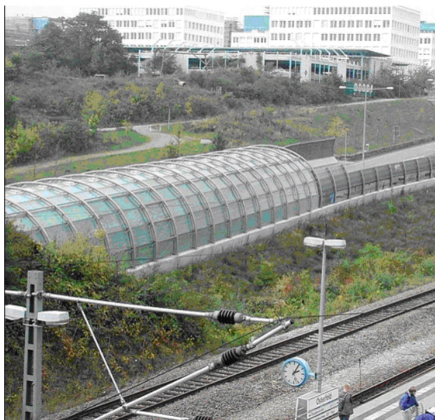
Schallschutzschiene Stuttgart-Vaihingen, Ortsumfahrung Vaihingen (Quelle: Städtebauliche Lärmfibel Baden-Württemberg)
