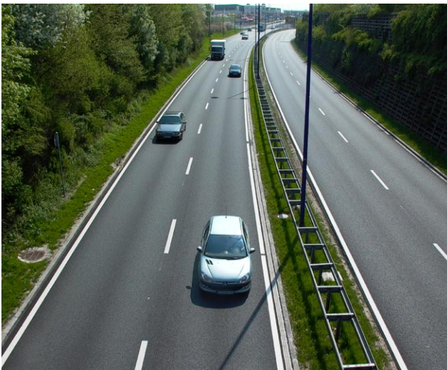
Zweilagig-offenporige Asphaltdeckschicht ("Flüsterasphalt"), innerstädtisch mit Geschwindigkeitsbegrenzung von 70 km/h (Augsburg, Foto LUBW)
