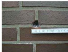
Bild 2: Löcher zur Befüllung
