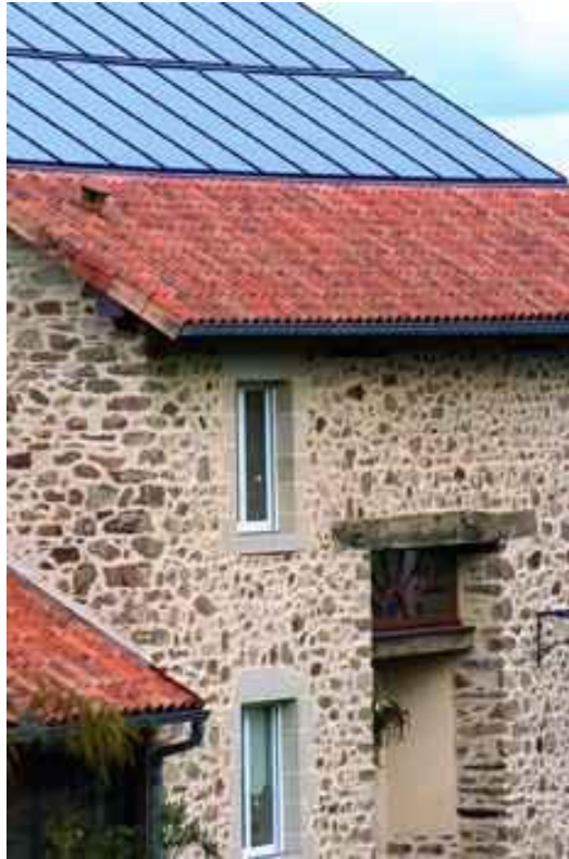
Abbildung 7: in das Dach integrierte Photovoltaikanlage
