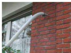
Bild 3: Füllschlauch am Mauerwerk
