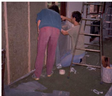
Innendämmung aus Mineralfaserplatten mit Dampfbremse; hier die Herstellung des Anschlusses am Fensterrahmen
