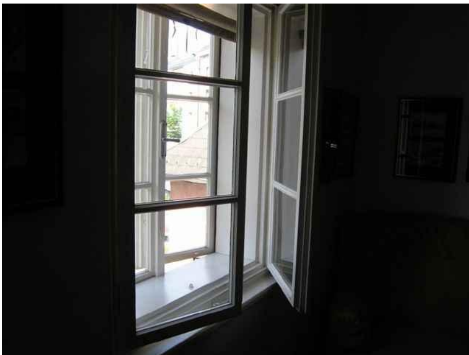
Abbildung 3: Aufbau eines Kastenfensters
