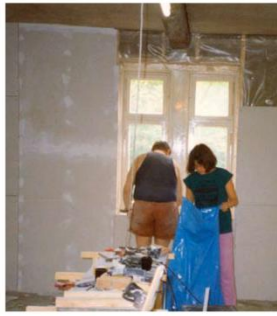
Montage einer Innendämmung in einem kleinen Bauernhaus Baujahr 1913 mit Mineralfaserdämmung, Dampfbremse und Gipskartonplatten.
