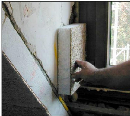
Die Dämmschicht wird, wie an dieser Gaubenwand, bis an den Fensterrahmen geführt.
