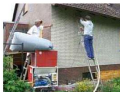
Bild 4: Einblasen des Dämmstoffs mit der Einblasmaschine
