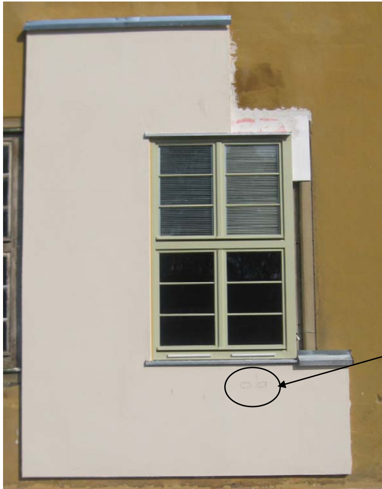
Montage Musterfläche, Unterputz fertiggestellt
