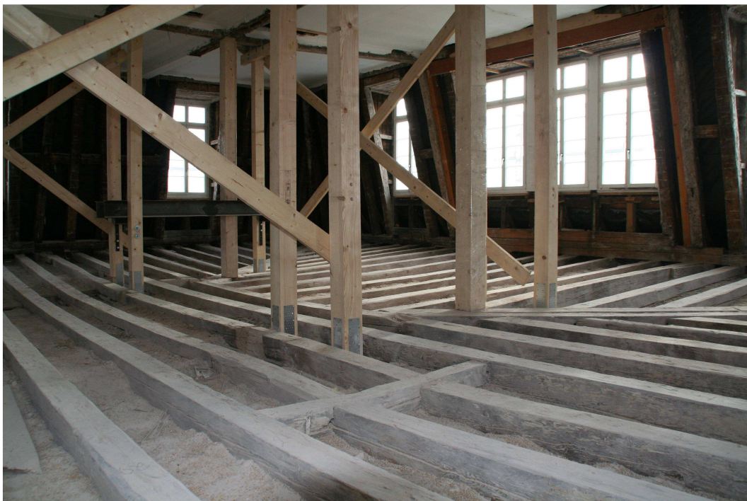
Abbildung 10: Gebogene Deckenbalken und provisorisches Traggerüst aus Holzbalken 177
