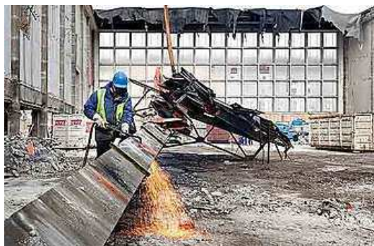
Abbrucharbeiten: in Wien wird das Skelett des alten Südbahnhofs entkernt. Foto: öbb
