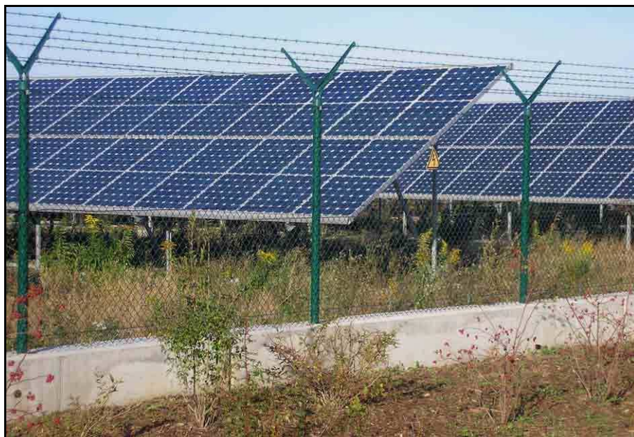
Abb. 3-1: Schutzzaun mit Sockelmauer – Entzug von Lebensräumen und Barrierewirkung (Foto: M. Reichmuth)
