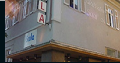
Scala Außenansicht vor Umbau 2010
